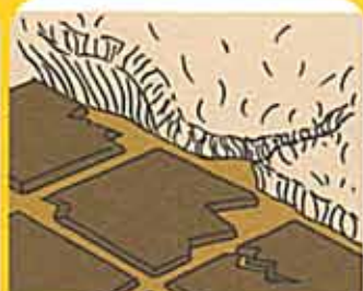
31- Moquette déchirée / carrelage cassé.
