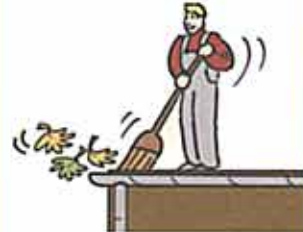
7- Personne qui balaie en bordure de toiture sans protection.
